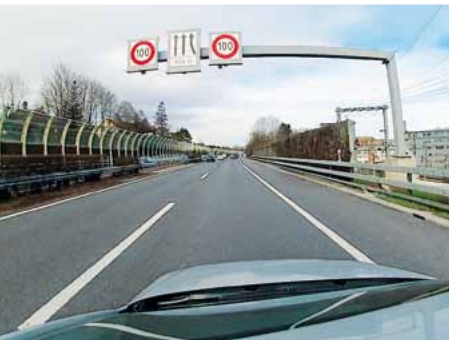
Das Signal kündigt an, dass der Pannestreifen als dritte Fahrspur hinzukommt.
